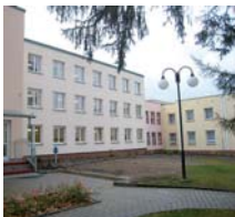
Nově rekonstruovaný pavilon C, D.
